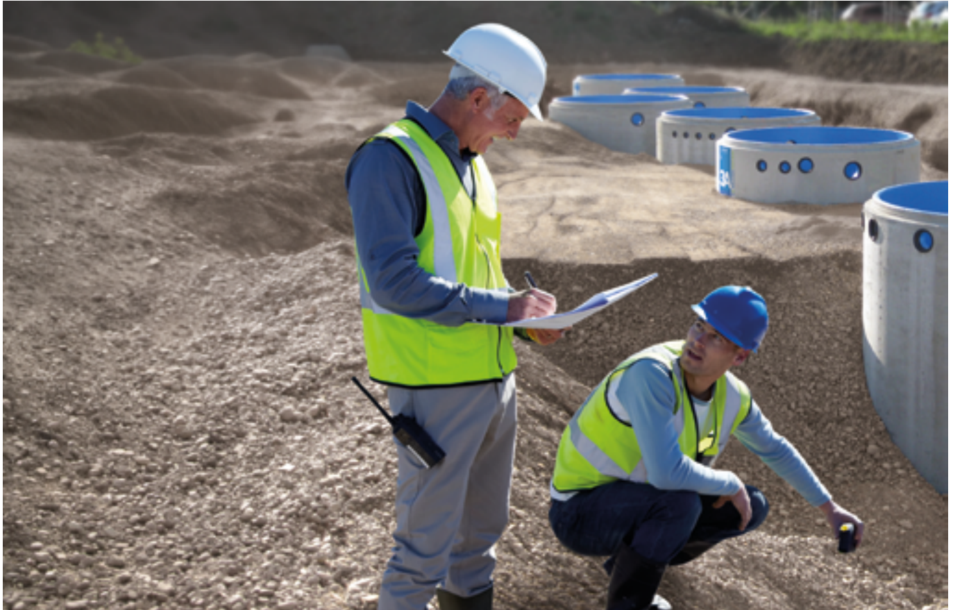
Maßarbeit auf der Baustelle: Exakt abgestimmte Behälterausführungen werden entsprechend den Höhenkoten versetzt
