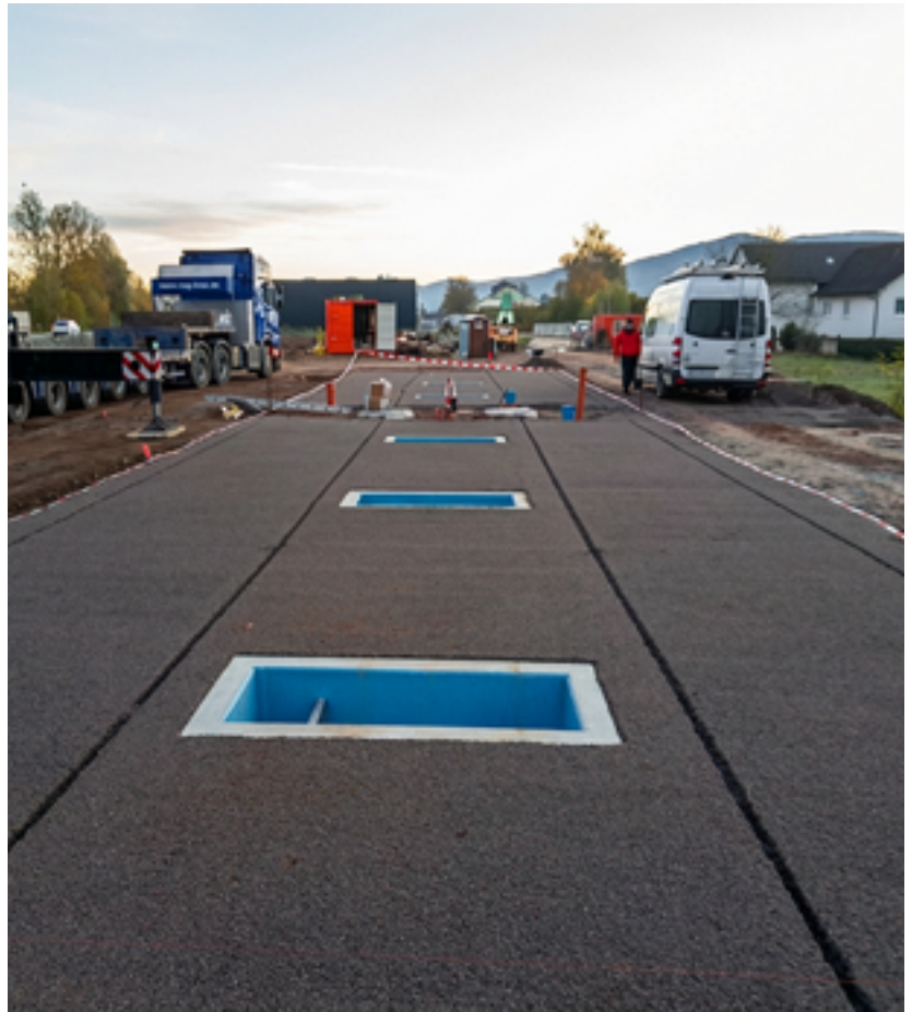
Beschichtete Vorschlammfänge beim Einbau
