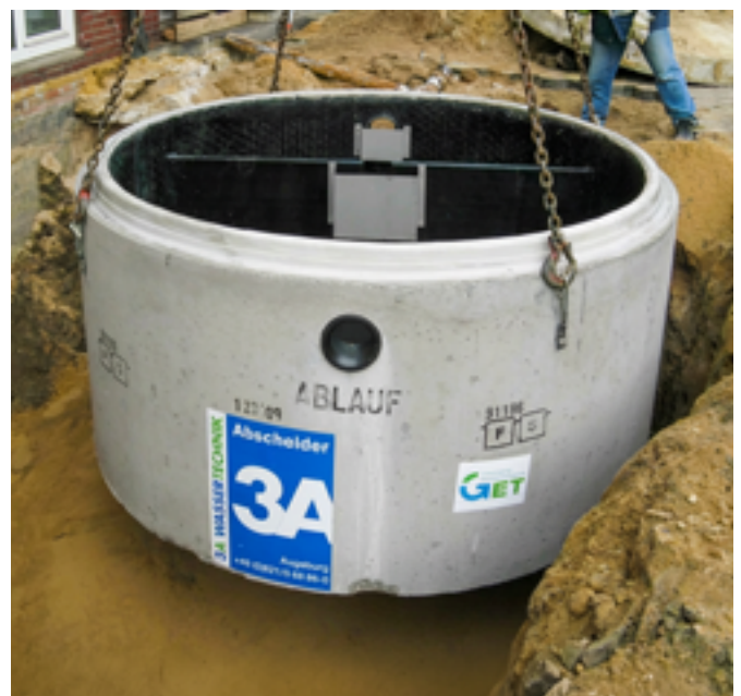
3A Kompaktanlage: Schlammfang und Fettscheider kombiniert mit Trennwand für bessere Reinigungsleistung.
