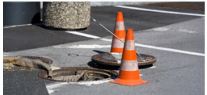
Wartung einer Schachtanlage
