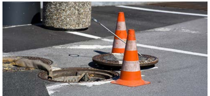
Wartung einer Schachtanlage
