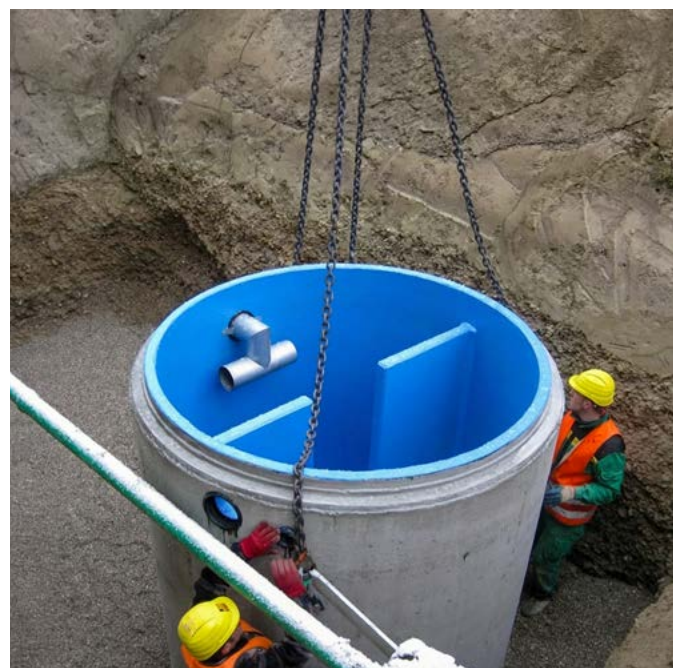
Funktionsbecken des Brauchwasser-Recyclings
