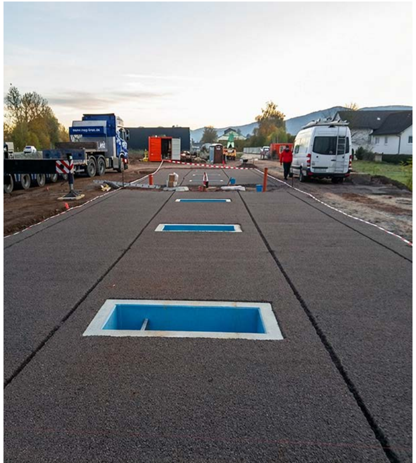
Beschichtete Vorschlammfänge beim Einbau
