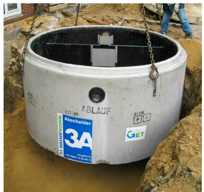
3A Kompaktanlage: sigma-Kompakt® Schlammfang und Fettabscheider kombiniert mit Trennwand für bessere Reinigungsleistung.
