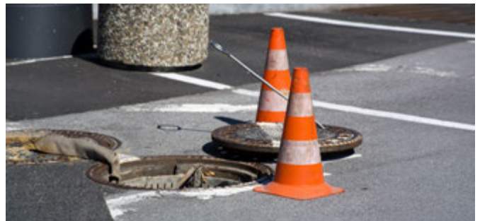
Wartung einer Schachtanlage
