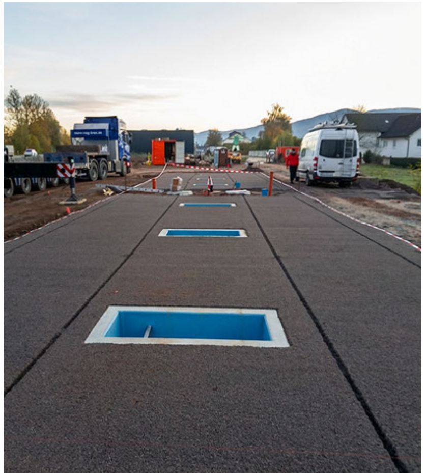
Beschichtete Vorschlammfänge beim Einbau
